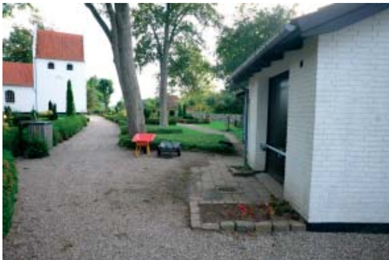
Det var i bygningen til højre med slåen for porten, at indbruddet fandt sted.
