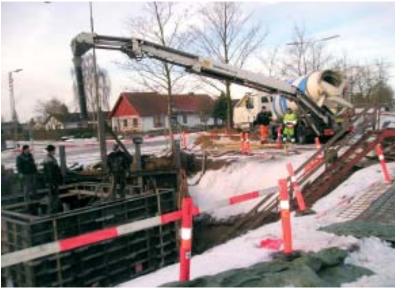
Betonkanonen i arbejde på grunden ved siden af Grethe Ecklons tandlægeklinik.
