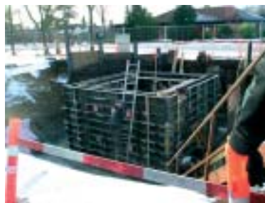
Støbekassen til bygningen, der skal rumme kloakpumperne.
